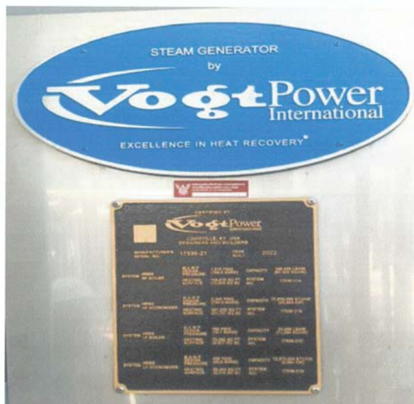
หน้าหน้าหมายเลขHRSG21 เลขเครื่อง 17536 – 21 Name Plate ; HP17536-21A, HPEC 17536-21B, LP 17536-21C, LPEC17536-21D
