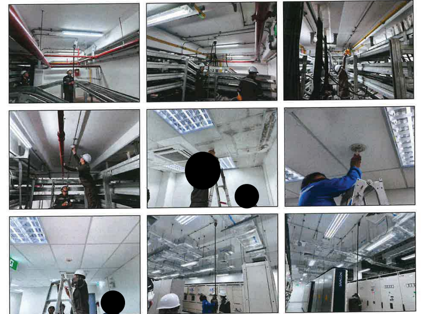
รูปที่ 2 ทดสอบการทำงาน Detector Zone 1 / Zone 2/Zone3/Zone4
