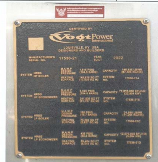
หมายเลขเครื่อง 17536 – 21 Name Plate ; HP17536-21A, HPEC 17536-21B, LP 17536-21C, LPEC17536-21D
