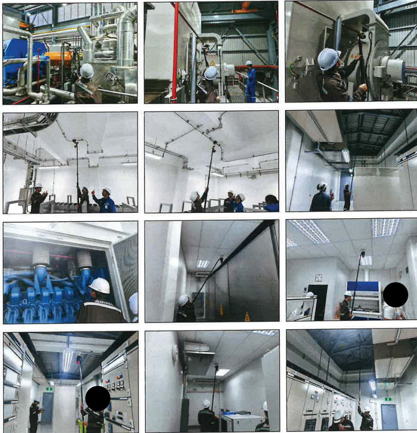
รูปที่ 2 ทดสอบการทำงาน Detector Zone 1 / Zone 2/Zone3/Zone4
